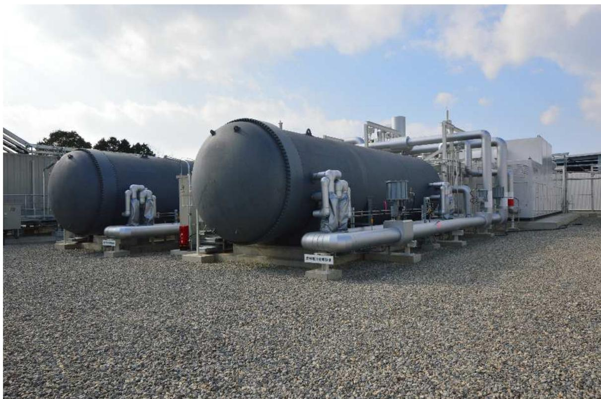
図1 第3段階の石炭ガス化燃料電池複合発電(IGFC)実証試験に用いる燃料電池設備
